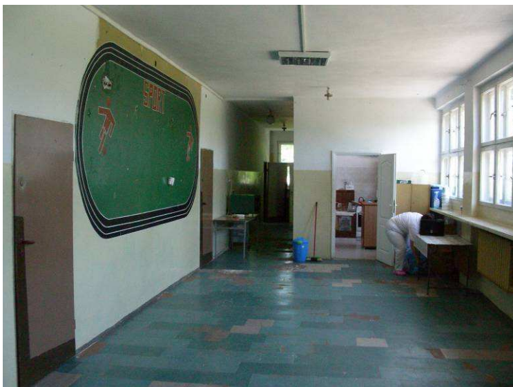
fot. 6 Pomieszczenie nr 0.2 (komunikacja)
