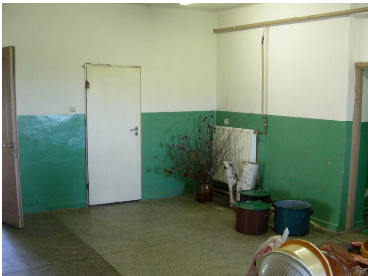
fot. 6 Pomieszczenie nr 0.02 (komunikacja)
