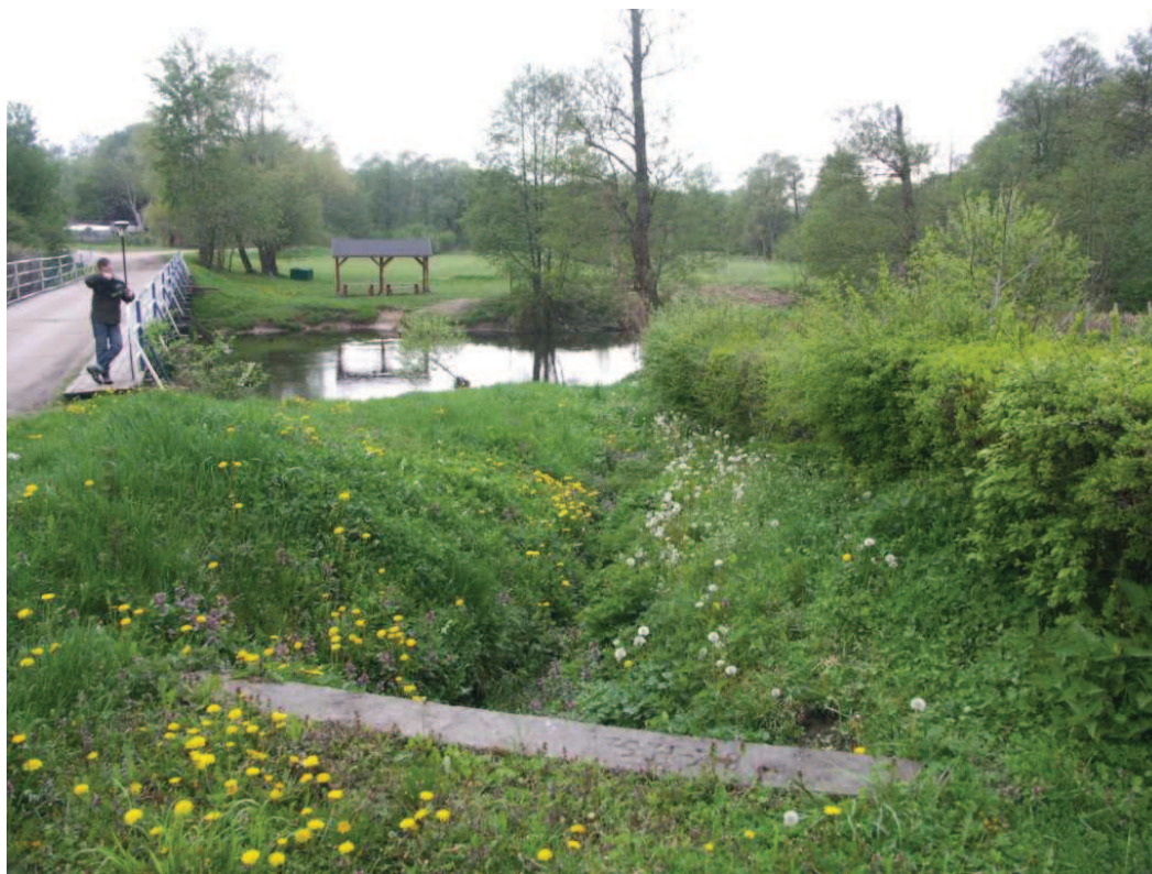
Fot. 1. Istniejący most przeznaczony do rozbiórki.
