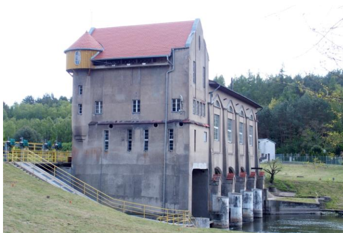
Zdjęcie nr 27. Elektrownia wodna w Bledzewie
